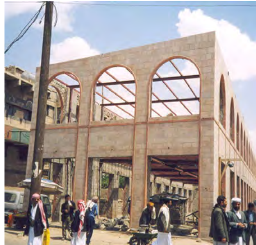
تكسية الهيكل الحديدي بالأحجار
