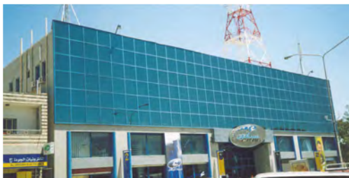
تكسية الهيكل الحديدي بالزجاج والمواد
