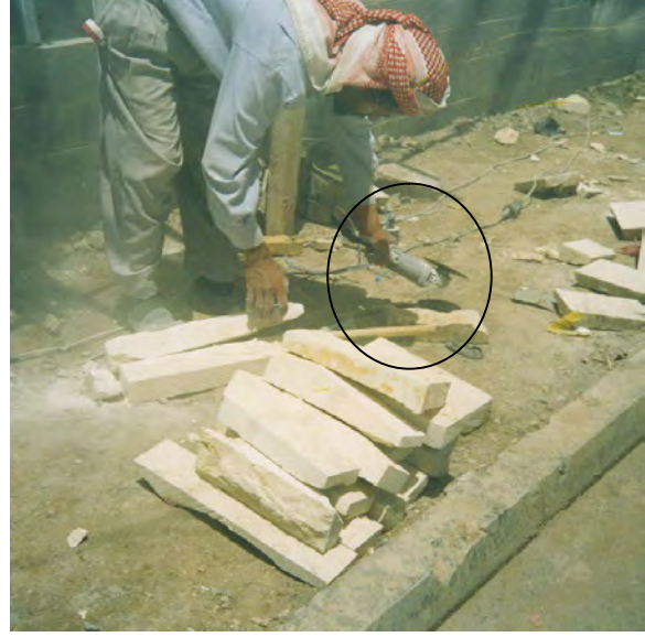
شكل ( ٥ - ٧ ) استخدام التقنيات الجديدة في قص الأحجار والوصول إلى
