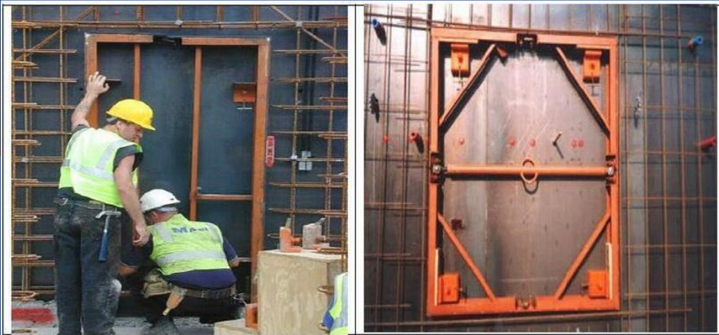
Installing door boxout
