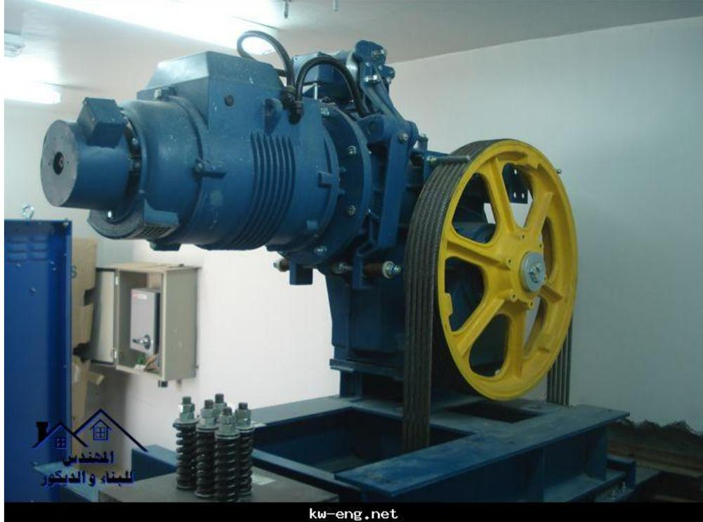
يتم التحكم بحركة المصعد بين الأدوار المختلفة بتمرير الحبال المعدنية التي تربط بين المقصورة وثقل الموازنة بمحرك كهربائي متصل ببكرة ويعمل بسرعات متعددة تحدد قدرته طبقاً لحمل المصعد ويتم التحكم بسرعة هذا المحرك وتوقفاته بتوصيله بلوحة كهربائية خاصة تكون مثبتة بجوار المحرك بغرفة المحركات وتغذى بالتيار الكهربائي ويجب الحرص على أن يكون هذا المحرك داخل غرف خاصة بالمحركات ويوضع فيها تكييف.
