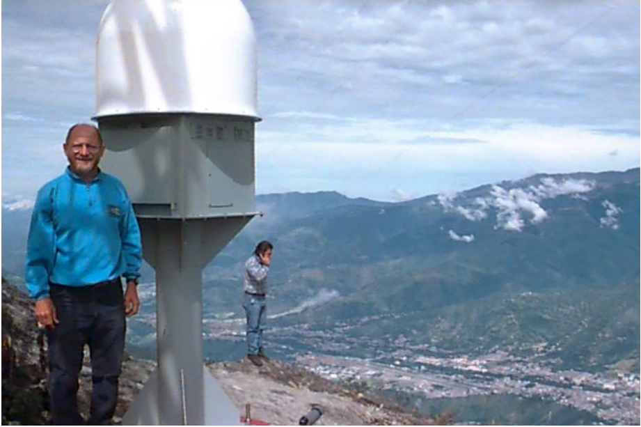
شكل 11.12: تركيب المحطة المركزية لشبكة ميريدا في لا أغوادا على ارتفاع 3600 متر.
