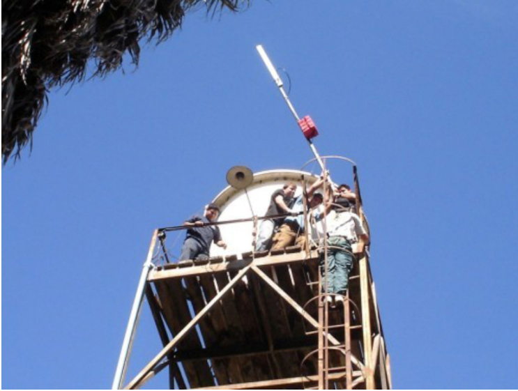
شكل 11.24: تركيب نقطة في أعلى برج للمياه في منطقة باتوكو Batuco لتوفير الإتصال بمركز الولوج البعيد في كابراتي Cabrati.
