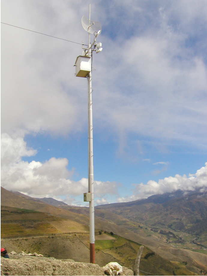
شكل 8.3: أحد الأشكال البسيطة للأبراج المدعومة ذاتياً.
