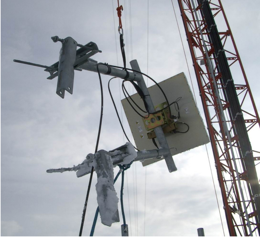
شكل 8.1: عملية رفع هوائي مركب على حامل إلى أعلى البرج.
