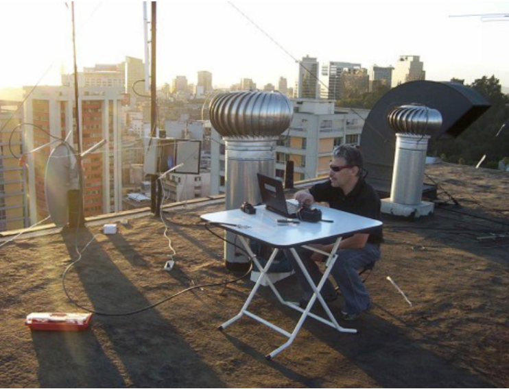
شكل 11.23: النقطة في وسط المدينة والتي تتصل بنقطة شمال سان دييغو. لاحظ استخدام الهوائي القطعي للوصلة البعيدة والهوائي المتقطع لربط الزبائن.
