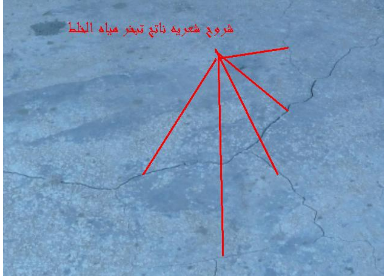
صورة الشروخ الشعريه ناتج تبخر مياه الخلط
