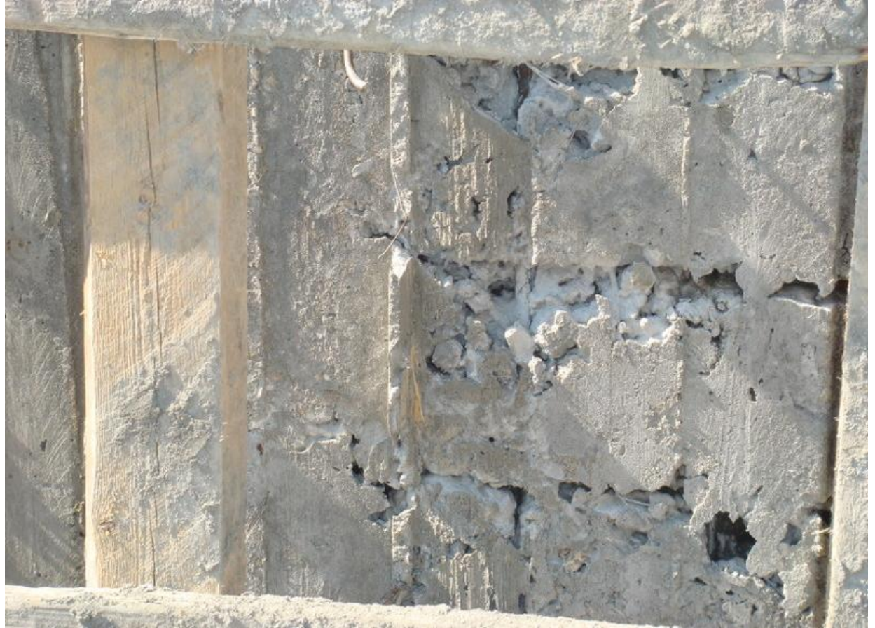
صورة التعشيش (تسويس) بالخرسانه
