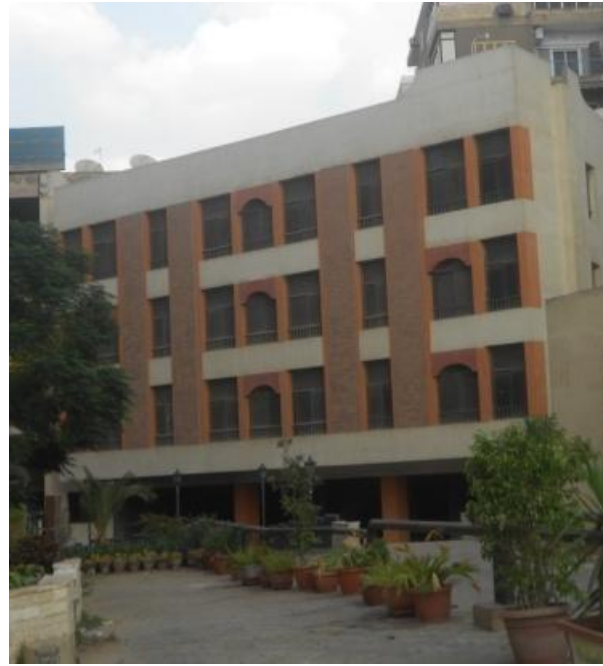
صورة توضح الألوان المنتسقة في واجهة المبنى وعدم استخدام مواد بناء تخيل بقوانين البناء
