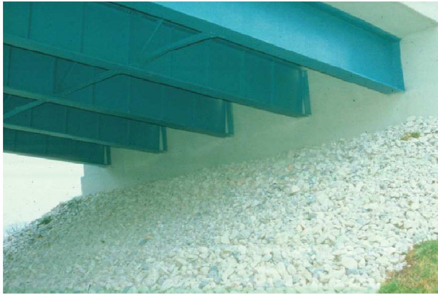
الشكل (٥١): رسم يوضح أقسام الركيزة الطرفية المتكاملة
