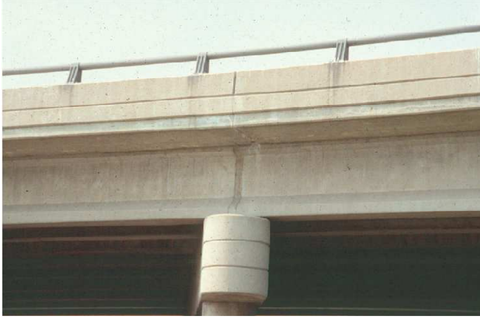
الشكل (١٧): أحد الجسور المستمرة ذات المقطع I
