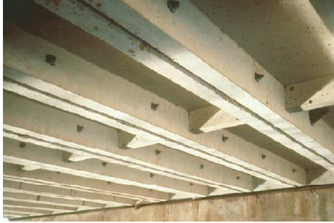
الشكل (٢٠): كمرات متجاورة ذات مقطع قناة
