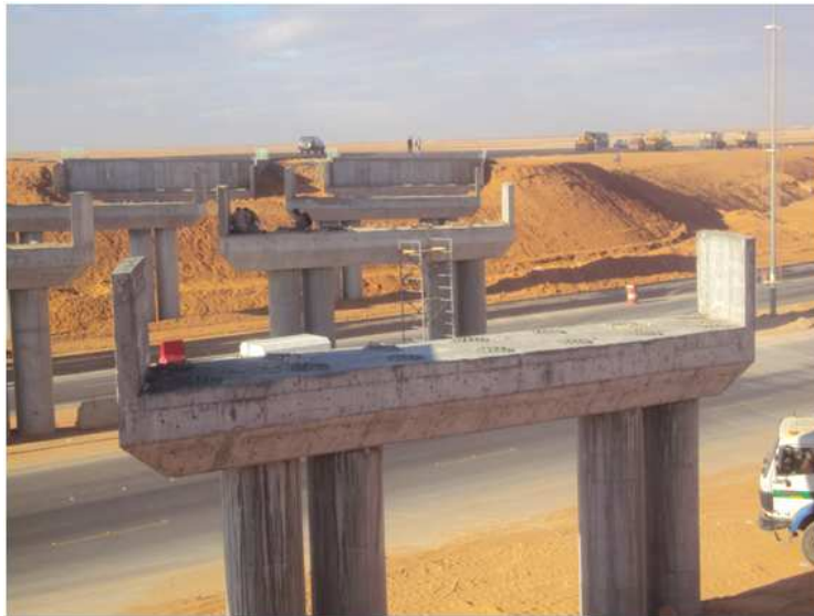
الشكل (٤٤): ركيزة الأعمدة ذات التاج
