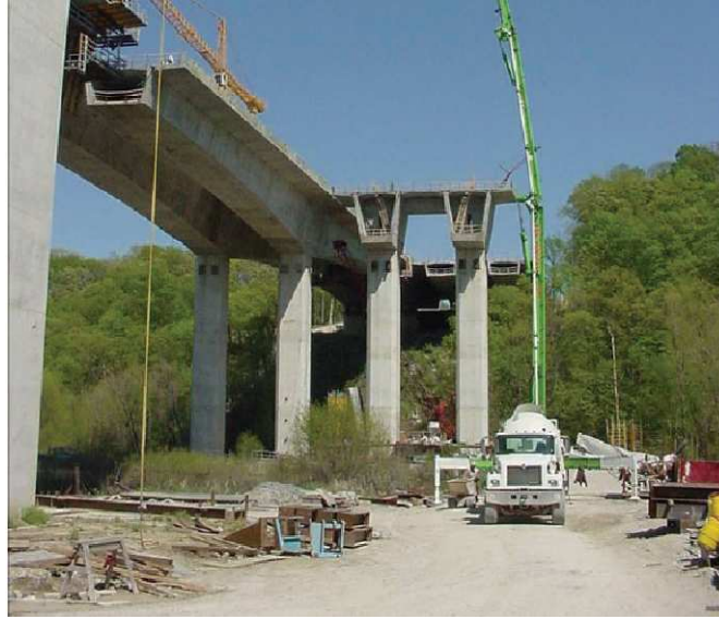
الشكل (٣٠): جسر ذو مقطع بعارضتين صندوقيتين
