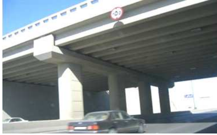
الشكل (١٢): أحد الجسور ذات مقطع تيه مسبق الصنع
