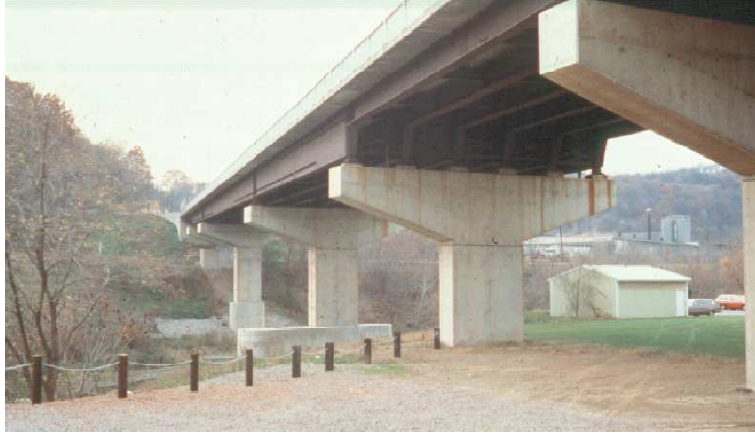
الشكل (٤٢): رسم يبين عناصر الركيزة الوسطية الكابولية أو ركيزة المطرقة
