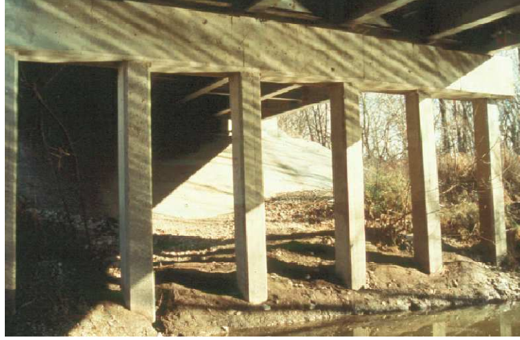
الشكل (٤٥): ركيذة الخوازيق ذات التاج
