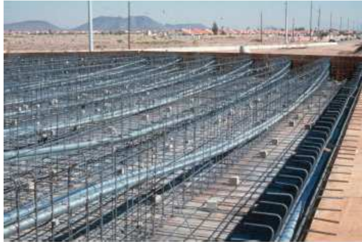
الشكل (٤): وضع قنوات الشد اللاحق أثناء التنفيذ
