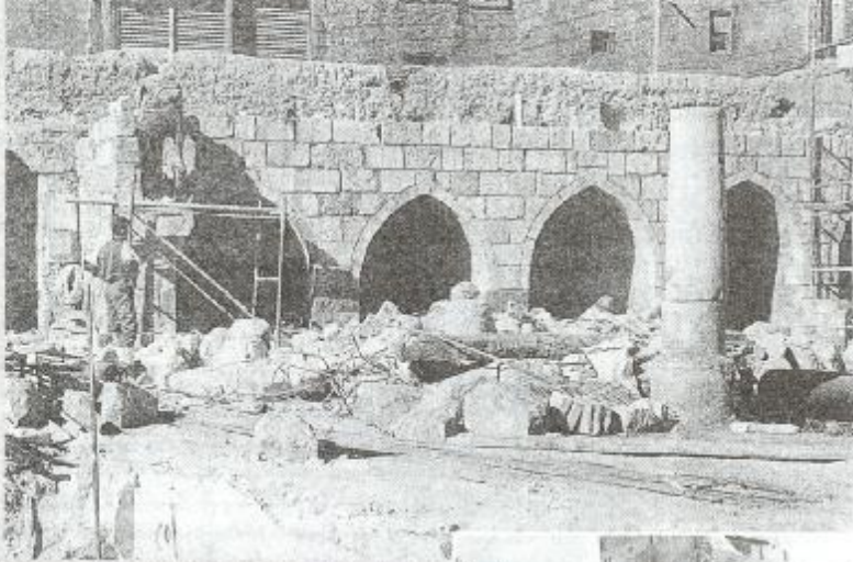
● الخنوات (غرف الطلبة) قبل الترميم وبعده
