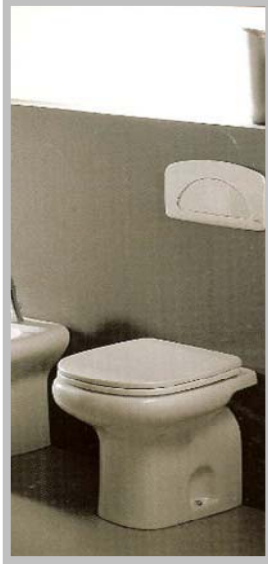
شكل رقم (١٢) - استخدام صمام الطرد بدلاً من صندوق الطرد في صرف المراحيض
