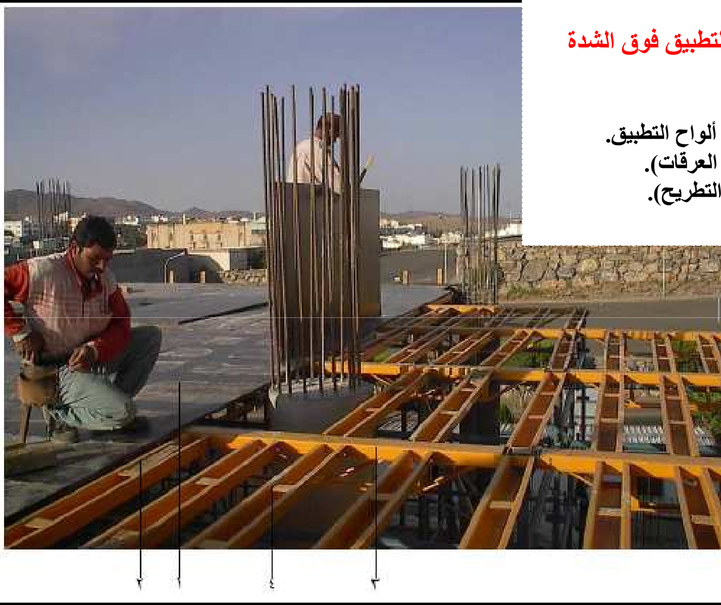
عملية تثبيت ألواح التطبيق فوق الشدة المعدنية
