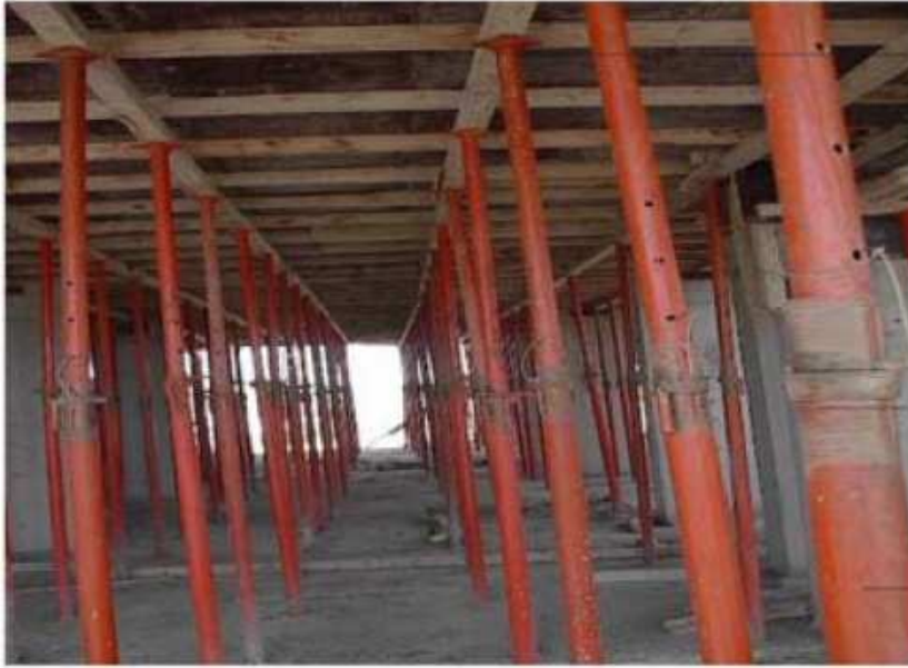
استخدام الدائم الحديدية في الشدات الخشبية
