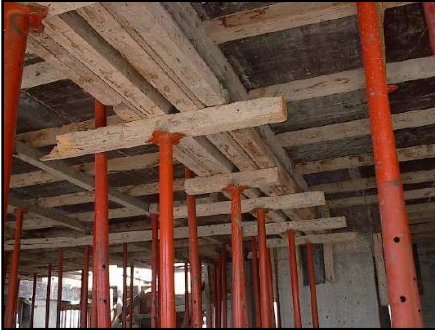
الشدة الخشبية لحزام ساقط أسفل السقف مع التدعيم بالدعامات الحديدية
