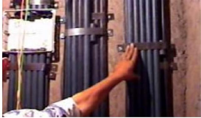
والصورة توضح ترتيب مواسير الكهرباء التى بها الكابلات وتجميعها بالصاعد
