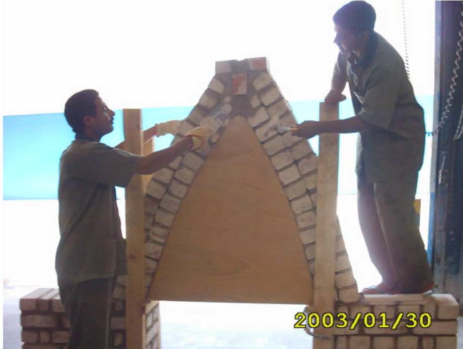
بناء المدماك الثاني
