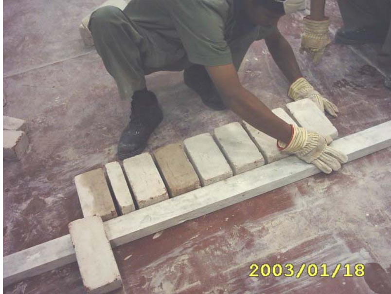
تثبيت القدة والزاوية الخشبية
