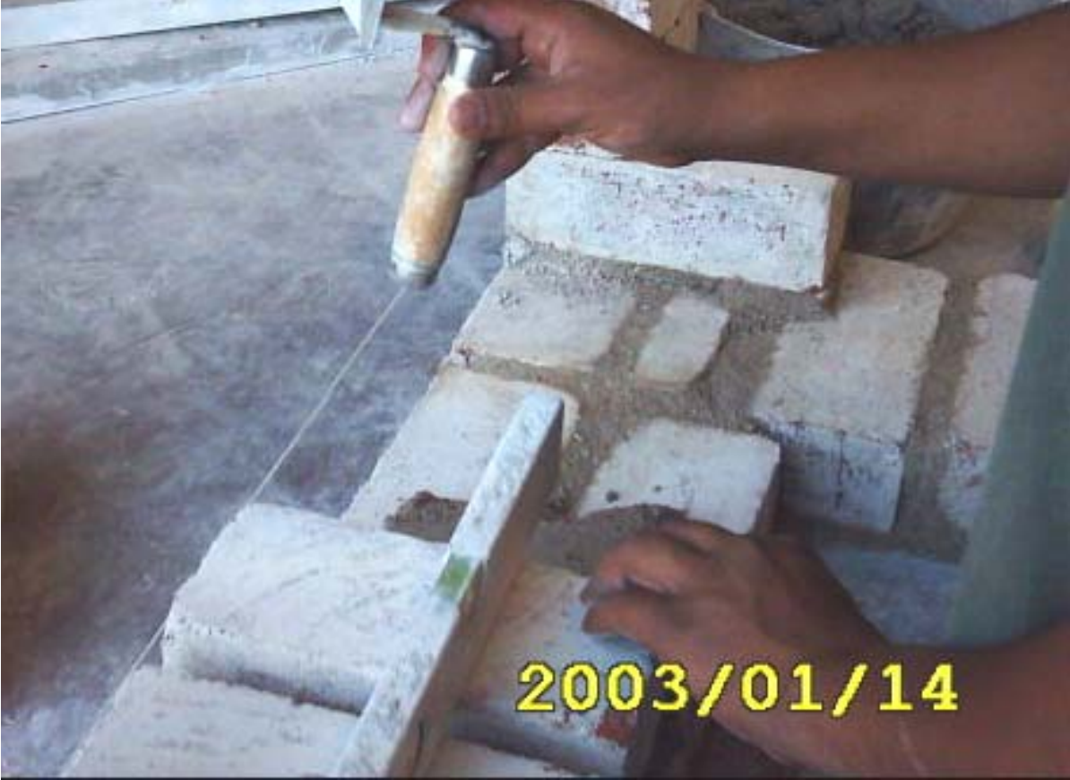
بداية بناء المدماك الثاني
