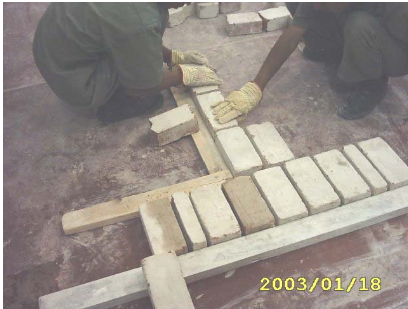
كيفية بناء المدماك الأول
