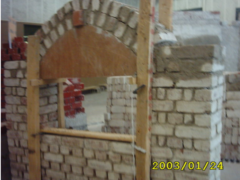
بناء المدماك الثاني
