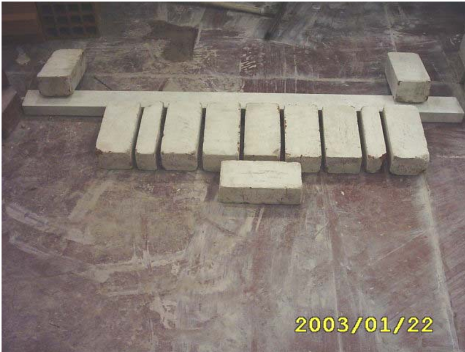
بناء المدماك الأول
