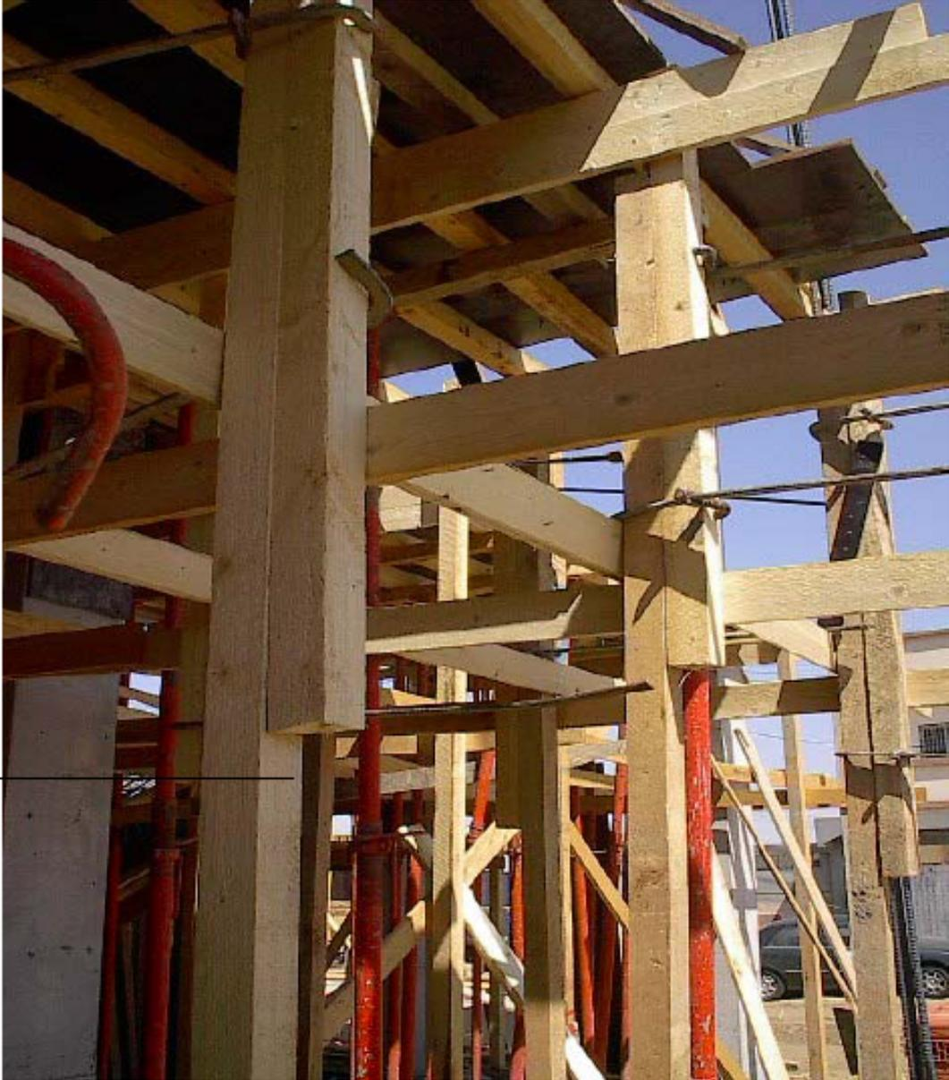
شكل رقم ( ٢١ ) استخدام القمط الحديدية في عمل ضفدعة (وصلات) رأسية لقوائم الأعمدة
