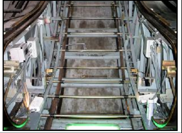
صورة توضح السلم قبل تركيب الغطاء الخارجي له موضح فيها التمديدات والمكونات للسلم
