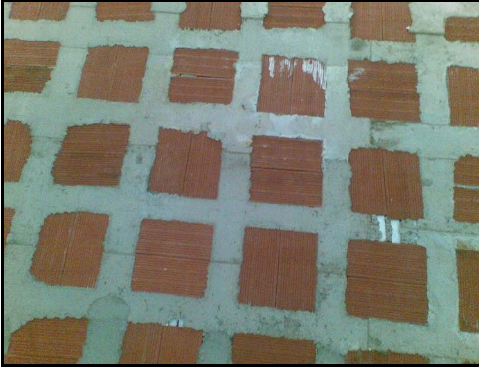
الشكل (٢ - ٧) يوضح شكل رص البلوكات في اتجاهين بعد الصب
