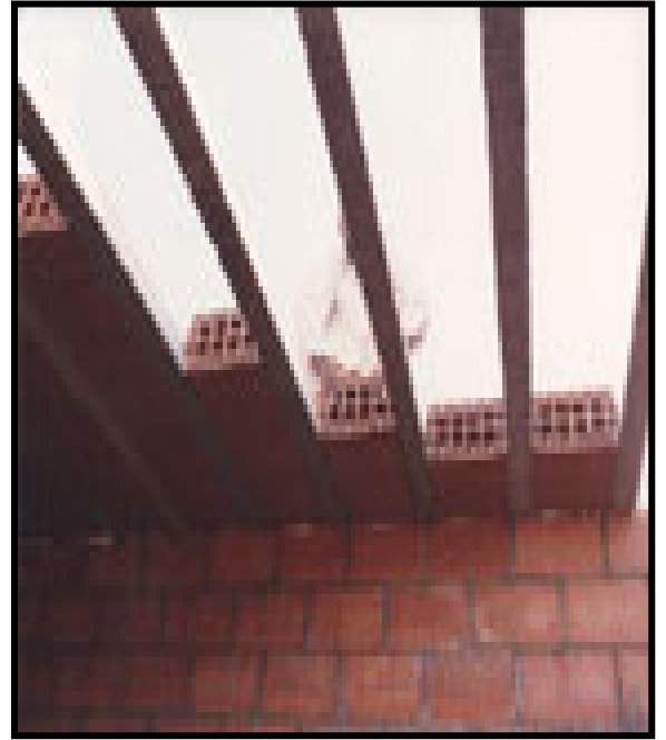
شكل (١ - ١٩) تفاصيل بناء السقف الهوردي من الأعصاب الخرسانية الجاهزة
