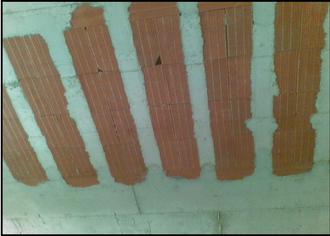
الشكل (٢ - ٥) يوضح شكل رص البلوكات في اتجاه واحد بعد الصب
