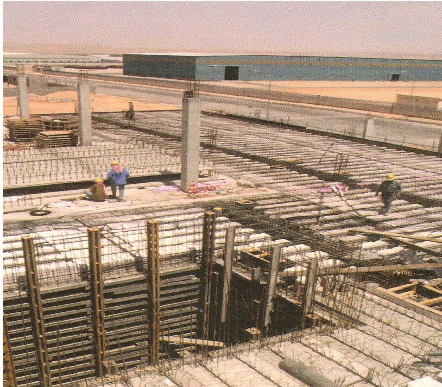
الشكل (٨ - ٢) يوضح شكل رص البلوكات المصنوعة من البلوستايرين
