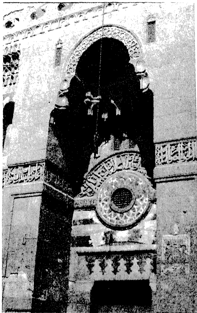
لوحة ١٥٥ - الواجهة الرئيسية للمدرسة والخانقاه
