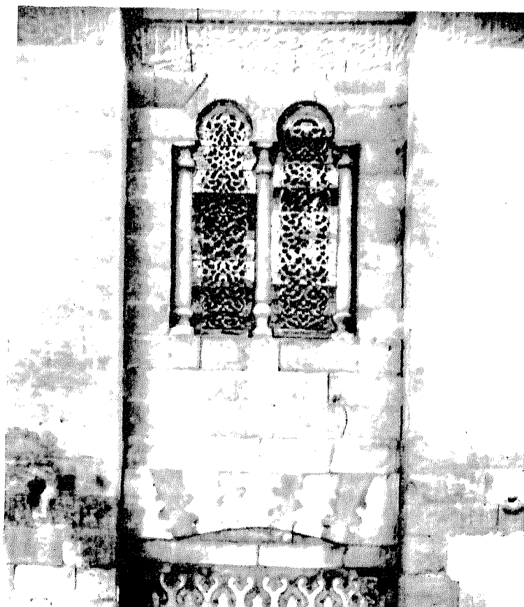
لوحة ١٣٧ - تفاصيل الواجهة الرئيسية
