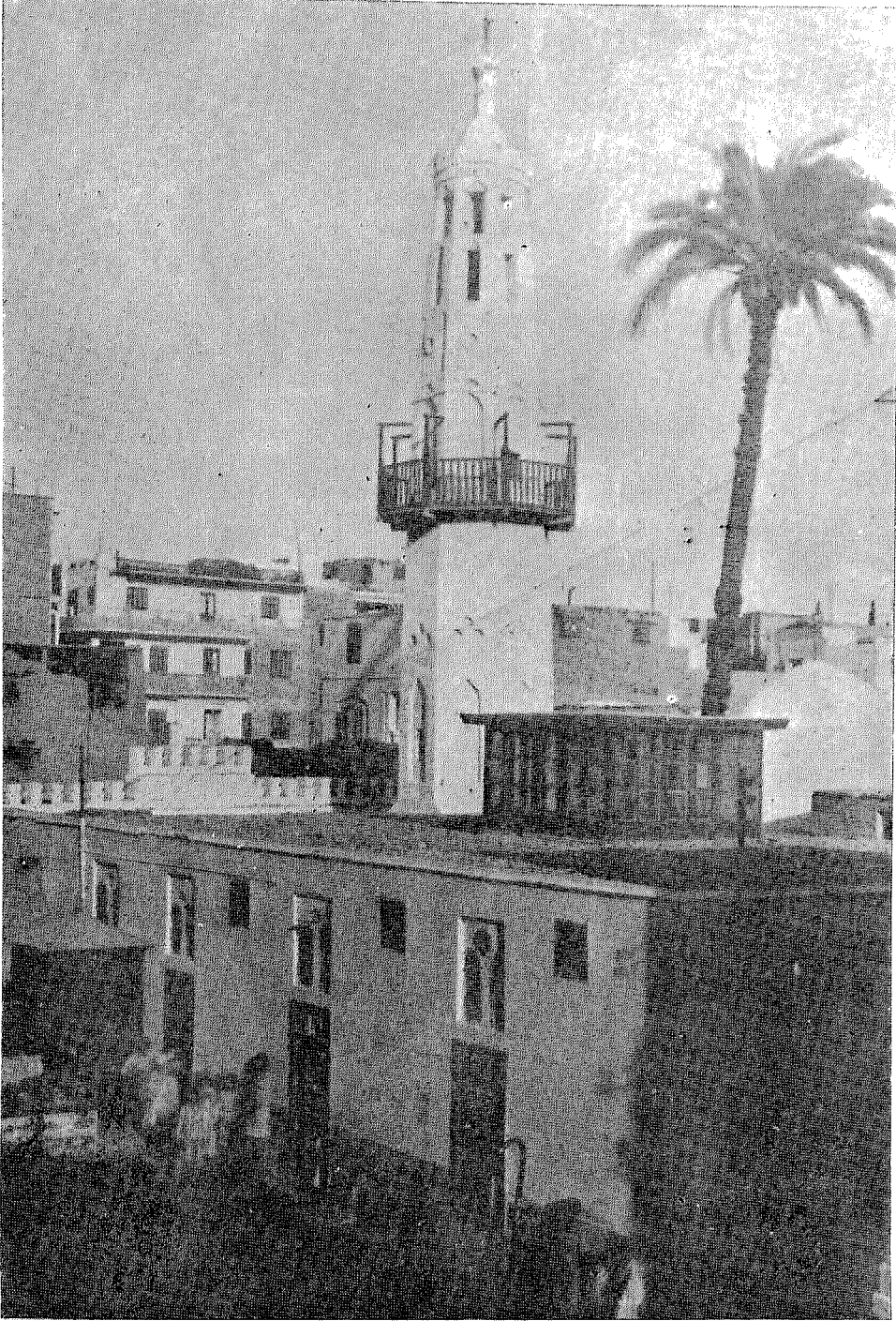
لوحة رقم ( ١٣١ ) تبين مسجد العسقلاني بمدينة ملوى ويرجع إلى القرن الثامن عشر
