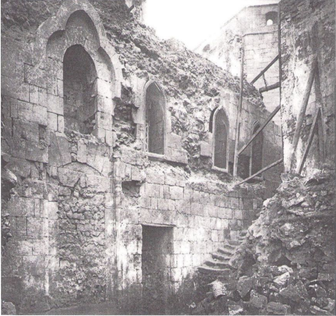
زاوية حسن الرومي (الواجهة الغربية قبل الترميم)
