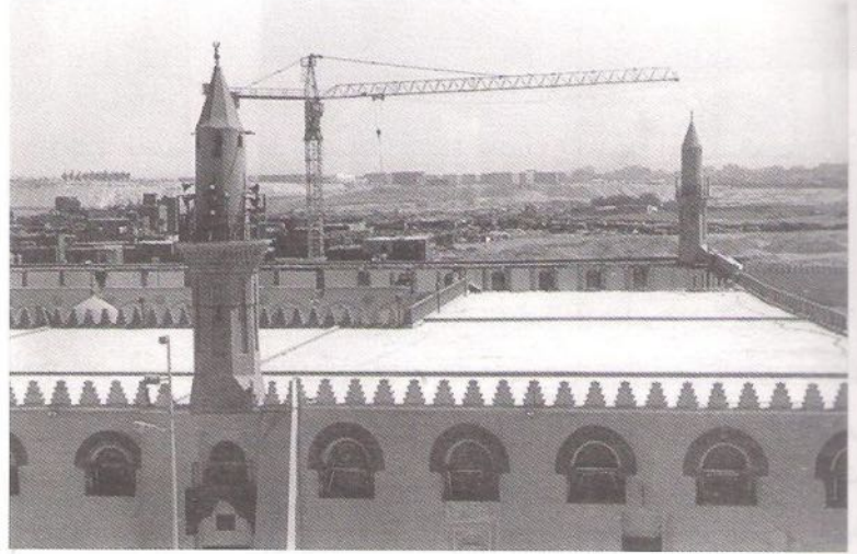
منارتا مراد بك بجامع عمرو (أثناء إعادة بناء إيوان القبلة)
