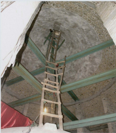
◀ القبة الكروية وفوقها القبة البصلية للمرقد الحسيني المقدس والفاصلة بينهما من الداخل . The spherical dome, above which the bulbous dome of the Holy Hussein Shrine and the interval in between.
