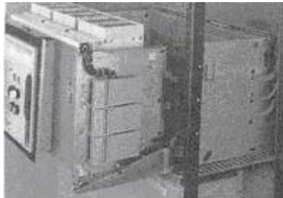
شكل (٣ - ٣) أحد القواطع المركبة في لوحة توزيع من نوع الأدراج
