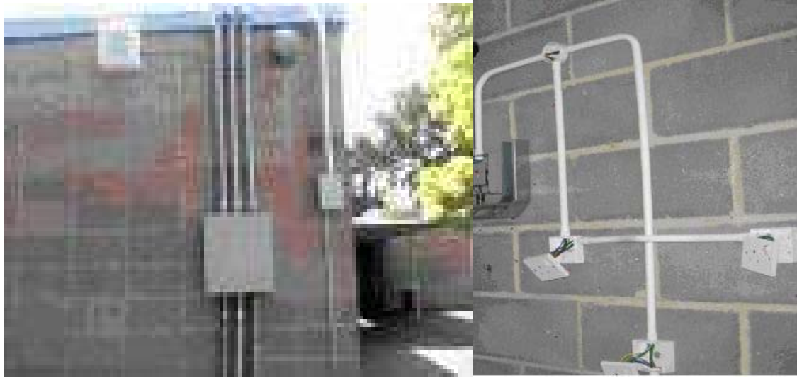
شكل (١ - ٤) تمديد الموصلات ظاهرة على الجدار داخل مواسير
