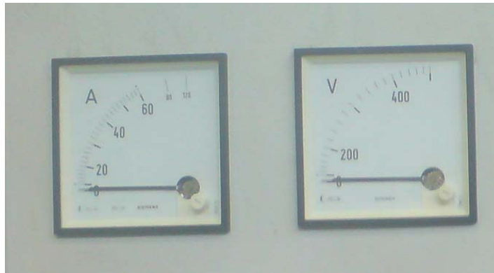
شكل (٣ - ١٦) أجهزة قياس الجهد والتيار
