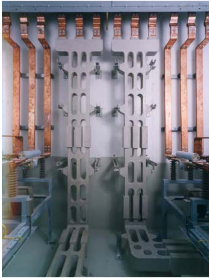
شكل ( ٥ - ٨ ) أشكال متعددة من قضبان التوزيع
