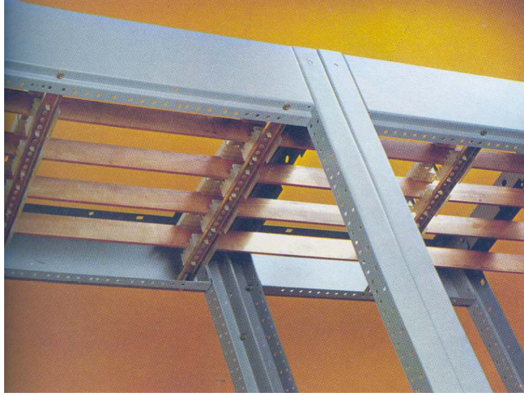
شكل ( ٥ - ٧ ) تركيب قضبان التوزيع بشكل أفقي
