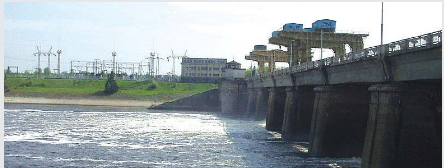
■ محطة مائية لتوليد الكهرباء.
