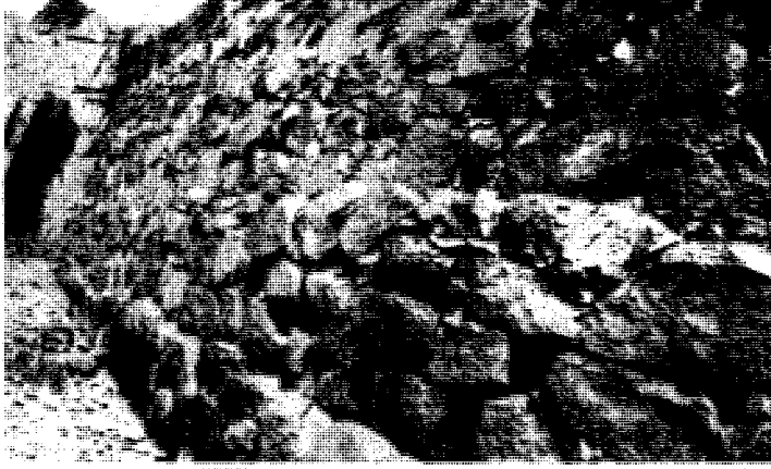
صورة رقم (٤١) : صورة أخرى للسد الثاني. ويبلغ طوله (٤٨.٥٠) م وارتفاعه (٦.٥) م وعرضه من أعلاه (٤.٣٠) م ويشابه بناؤه بناء (سد أنال).
