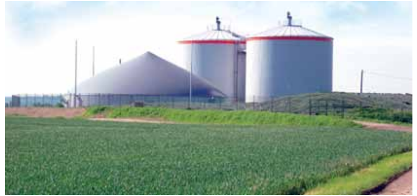
وحدة لإنتاج البيوغاز من النفايات الزراعية والحيوانية في مزرعة قرب بلدة فوكنشتاين في ألمانيا. يتم هضم المواد العضوية لاهوائياً لإنتاج الغاز الحيوي الذي يستخدم لتوليد الطاقة
