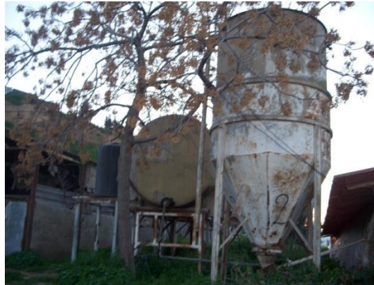
خزانات المياه و الأعلاف
