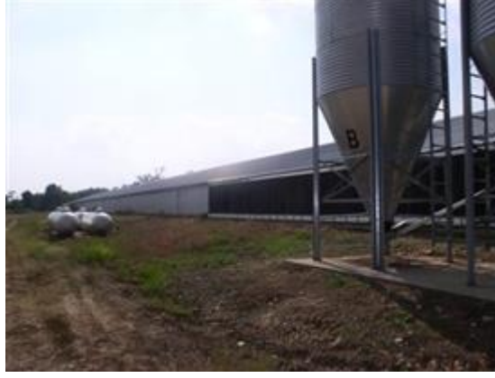
صورة توضح الصوامع التي تغذي العنابر بالاعلاف والمياة
