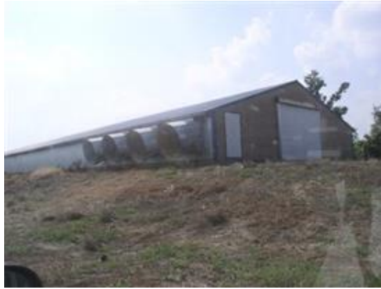
صورة توضح العنبر من الخارج وبها ايضا توضح مراوح التهوية
