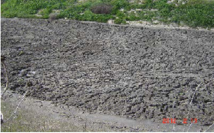
الشكل 6 - 44: أحد أحواض التجفيف المليء بالحمأة في طور التجفيف.
