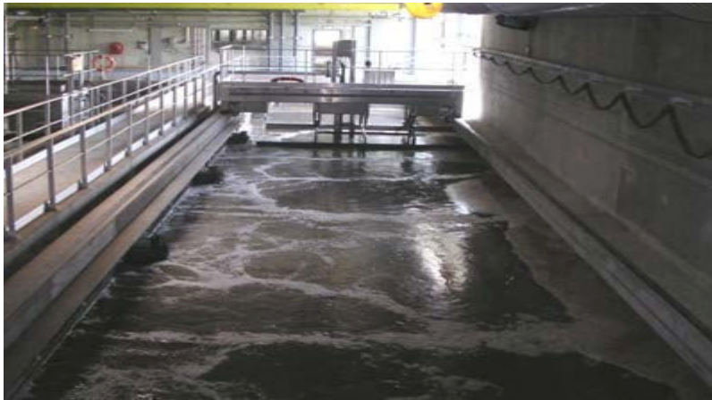
الشكل 5 - 3: صورة حوض إزالة الزيوت بنظام الشفرات المتحركة.
