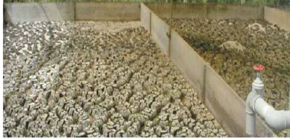
الشكل 6 - 33: الحمأة الجافة في سرير تجفيف الحمأة.
