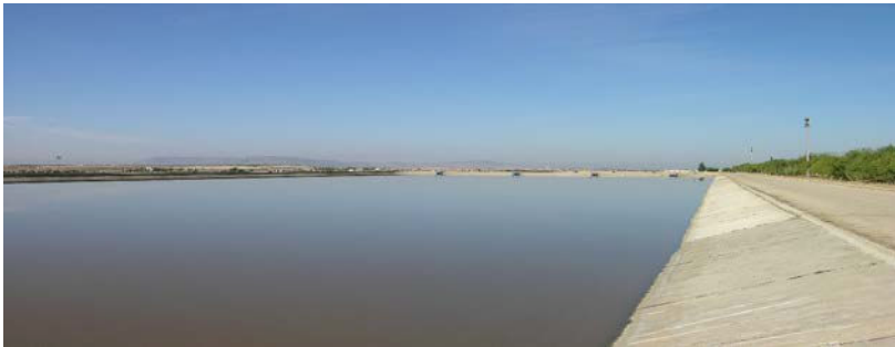
الشكل 6 - 43: أحد أحواض التهوية (الأكسدة) الطبيعية.
