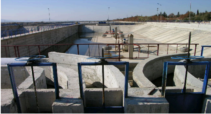
الشكل 6 - 41: حجرة توزيع الماء ويظهر أحواض التهوية الآلية خلفها في حالة التفريغ مع المهويات في حالة توقف.
