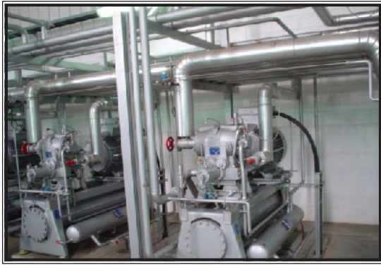
شكل (13.4): نظم التبريد باستخدام الضواغط اللولبية الدوارة.
