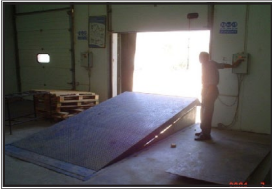
شكل (5.9): جهاز ضبط المستوى لرصيف التحميل من الداخل.
