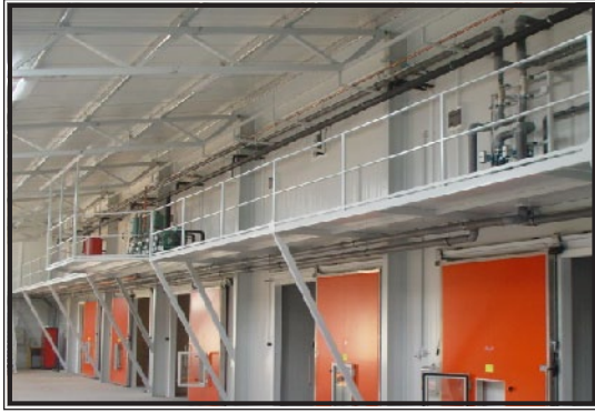
شكل (5.6): غرف جو هوائي متحكم به يوضح الأبواب الإضافية ذات النافذة الزجاجية (Thompson, 2002).
