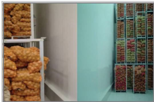
شكل (7.4): الفجوات ما بين الجدار وعبوات المنتج بفعل الركبة الحامية لجدران المخازن.
