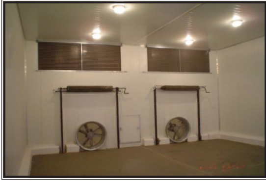
شكل (5.5): نظام تبريد سريع جاف بنظام التمدد المباشر.
