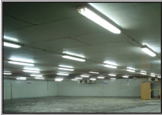
شكل (5.12): نموذج لتدهور الأرضيات بأحد مشاريع التبريد.
