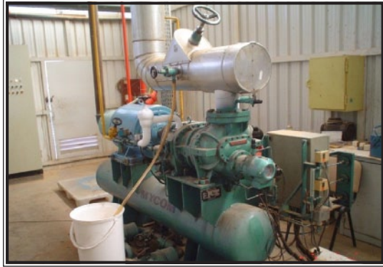
شكل (6.12): بعض عمليات الصيانة تتم بصورة غير آمنة.
