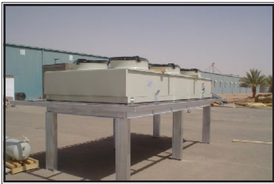
شكل (14.4): مكثف هواء بأحد مشاريع تبريد للخضروات والفاكهة.
