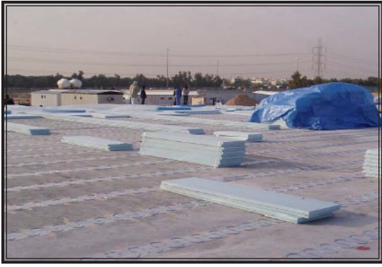
شكل (8.12): عزل ما تحت أرضية مخازن التبريد بالسخانات الكهربائية.
