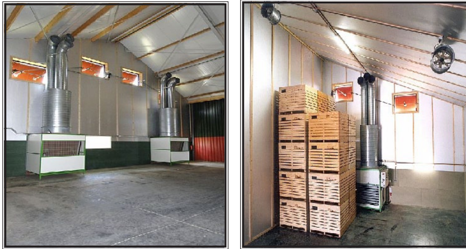
شكل (7.14): وحدات التبريد ذات الإرتكاز الأرضي.
