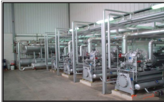
شكل (14.12): غرف المحركات بدون علامات إرشادية.
