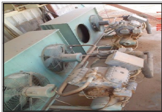
شكل (3.12): غياب الصيانة وقدم وحدات التبريد.
