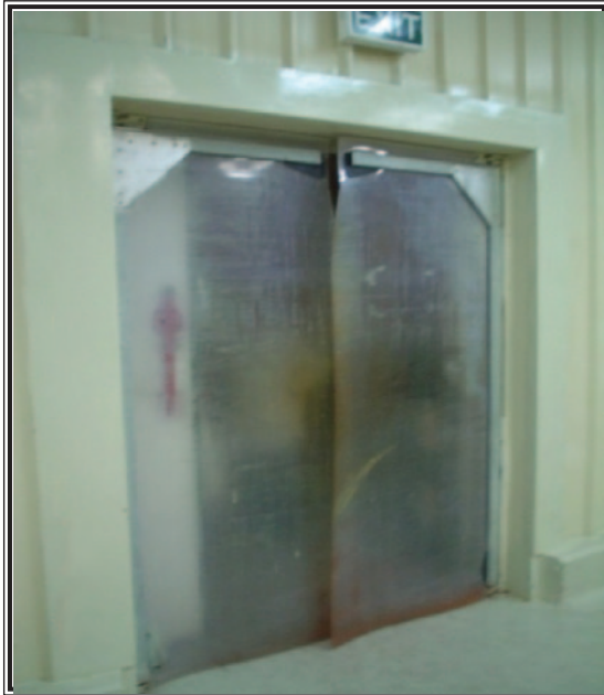
شكل (5.2): أبواب بلاستيكية للحد من اختراق الهواء الخارجي لغرف التبريد.
