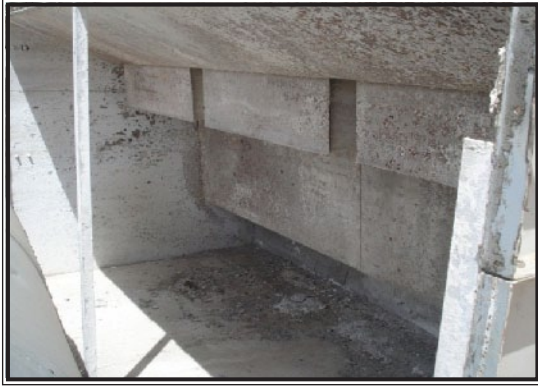
شكل (4.12): مكثف تبخيري تتراكم عليه القشور بفعل أملاح المياه غير المحللة.
