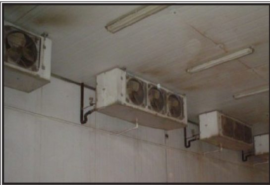
شكل (2.12): قدم المبخرات بأحد مشاريع التبريد للخضروات والفاكهة.
