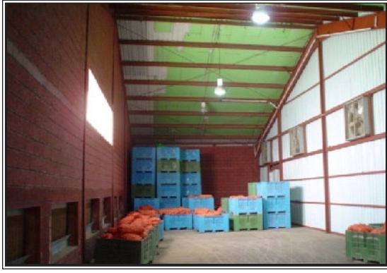
شكل (6.3): عدم عزل جدران غرف التبريد التبخيري.
