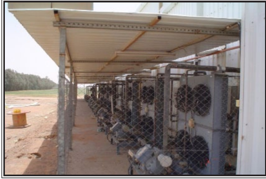
شكل (2.3): المساحات الكبيرة المطلوبة لمعدات التبريد بنظام التمدد المباشر.
