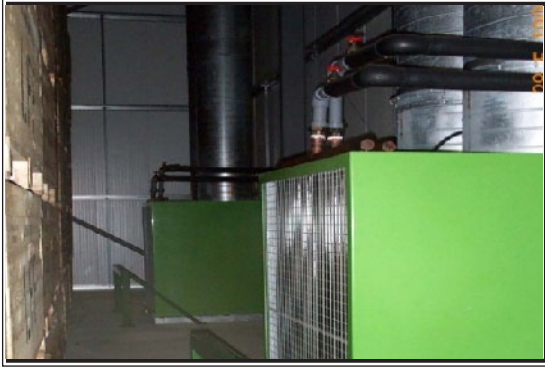
شكل (5.3أ): مبرد مائي لمحطة تبريد خاصة بالبطاطس (أعلى) وملفات التبريد بغرف البطاطس (أسفل).
