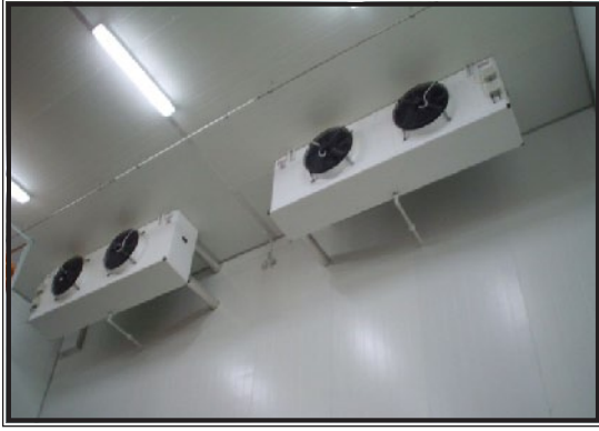
شكل (11.4): مبخرات مخازن التبريد.
