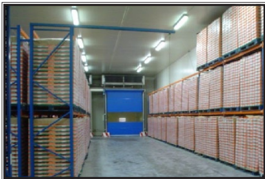
شكل (6.4): الفجوات بين بالئات المنتج لغرض تدوير الهواء بمخازن التبريد.
