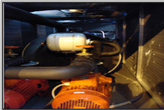
شكل (5.3أ): مبرد مائي لمحطة تبريد خاصة بالبطاطس (أعلى) وملفات التبريد بغرف البطاطس (أسفل).
