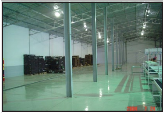
شكل (12.9): حماية أرضيات المشروع بالإيبوكسي.
