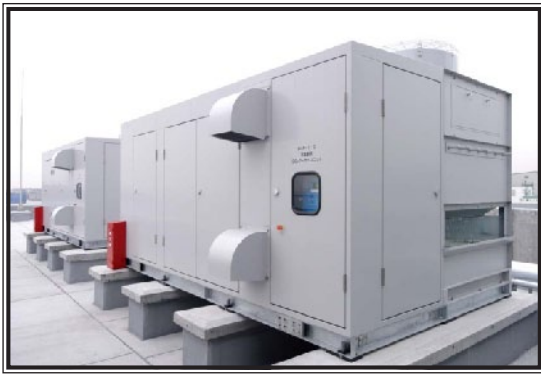
شكل (2.10): نظام تبريد باستخدام النشادر/ثاني أكسيد الكربون.
