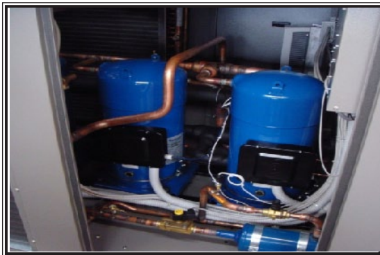
شكل (5.3ب): ظلمبات تدفق الجليكول (أعلى) وضواغط التبريد (أسفل) لنفس المبرد.
