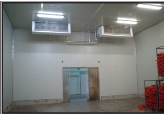
شكل (11.12): غرف تبريد لخزن البطاطس بدون نظام إطفاء للحرائق.
