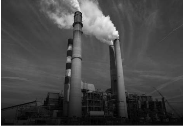
شكل (4) محطة كهرباء شبرا الخيمة "البخارية"
