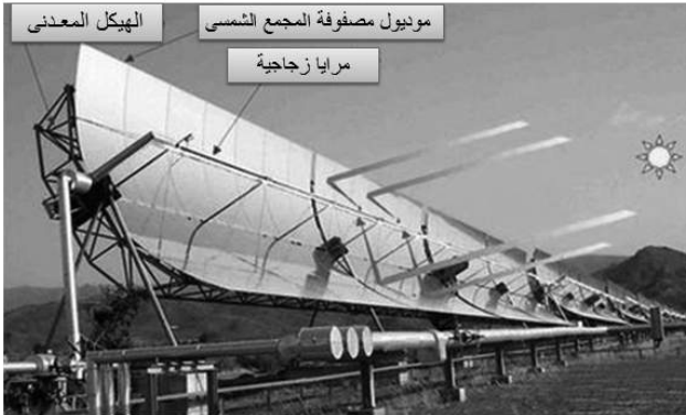
شكل (26) مثال لمكونات موديول مصفوف
