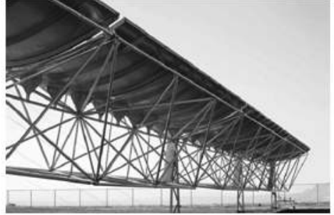
شكل (11) هيكل التثبيت المجمع
