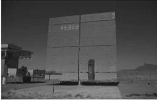
شكل (23) هليوستات من مرايات زجاجية معدنية مسطحة قياسية Source: (GEEN 4830-ECEN 5007)
