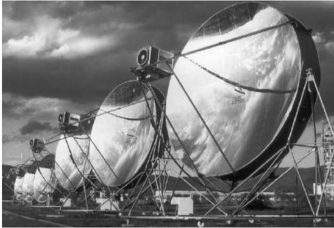
شكل (4) حقل مجمعات طبق قطع مكافئ
