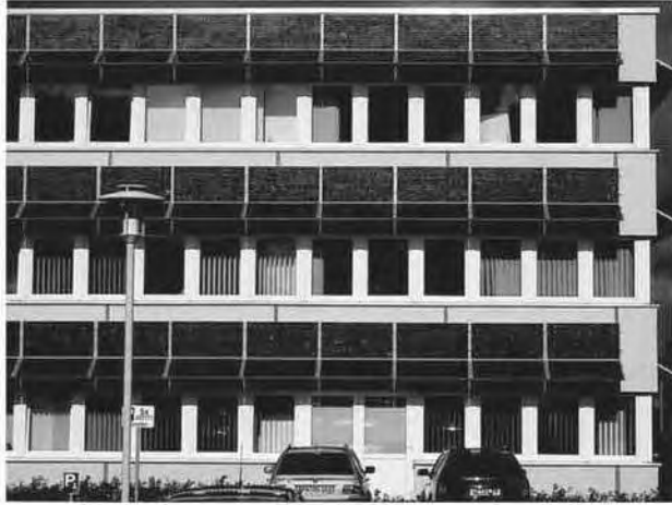
الشكل (10-13): واجهة بمنظومات فولتضوية كحواجب للنوافذ للتقليل من حمل مكيف الهواء وكزخارف (شوهدت في سولارورلد (Solarworld) في مدينة فريبيرغ، ساكسوني (Saxony)).
