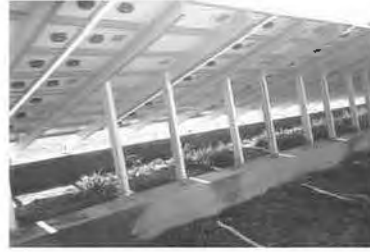
الشكل (18-2): إنشاء تقليدي من خرسانة إسمنتية وألمنيوم للقاعدة، وبنية الدعامه، والتركيب (مركز أبحاث الطاقة الكهربائية (CEPEL)، ريو دي جانييرو).
