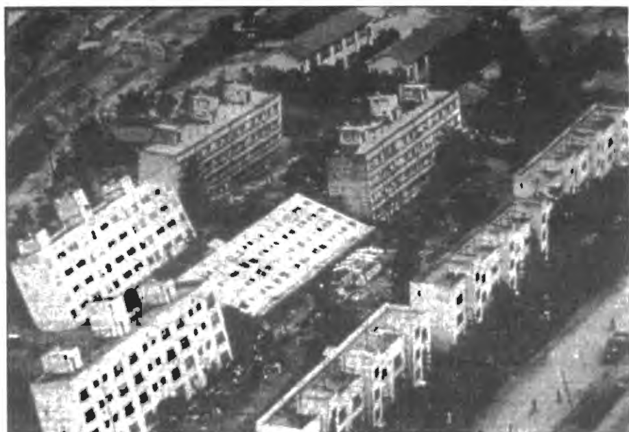
شكل (٦، ١١) إسالة التربة أثناء زلزال في ١٦ يونيو ١٩٦٤، بما أدى إلى انقلاب هذه المباني بالشقق السكنية في نايجاتا باليابان. ( الصورة باذن من المركز القومي للبيانات الجيوفيزيائية)
