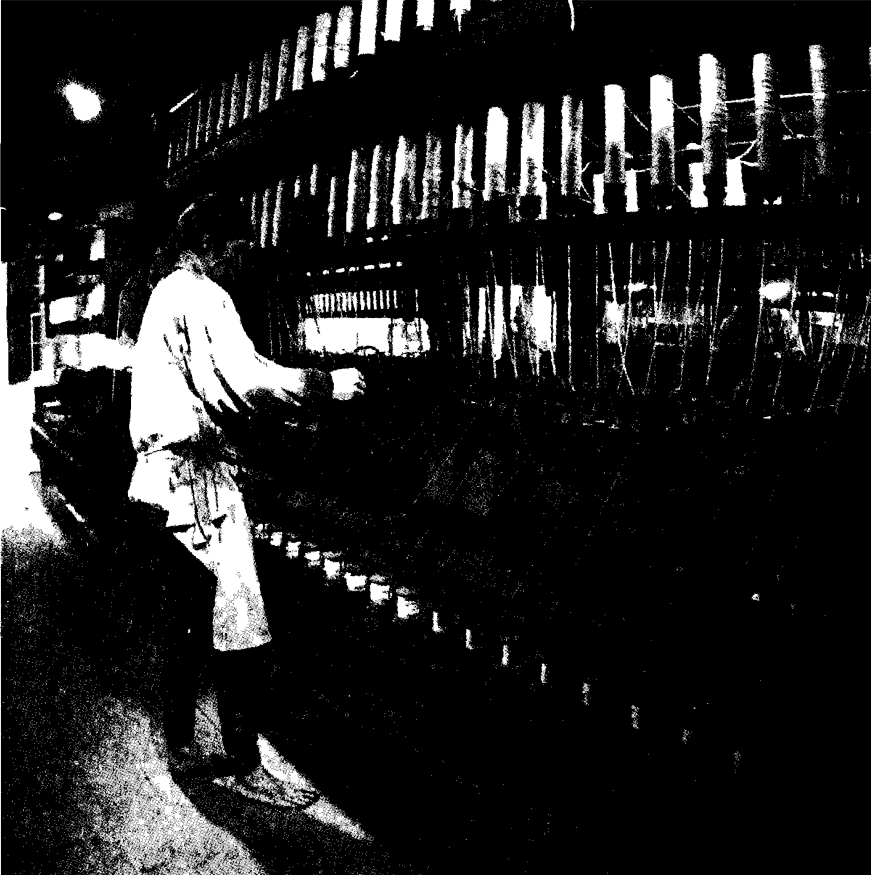
الشكل 12 - 2: ماكينة غزل تعمل بالطاقة المائية في مصنع كرومفورد الذي أسسه ريتشارد آركريت، في العام 1785.
