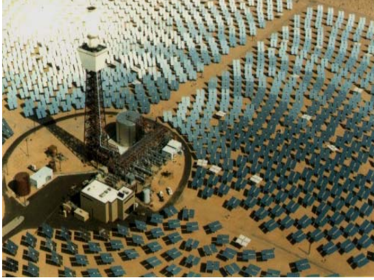
شكل (2) : صورة لمحطة شمسية تعتمد علي تقنية برج القوي
