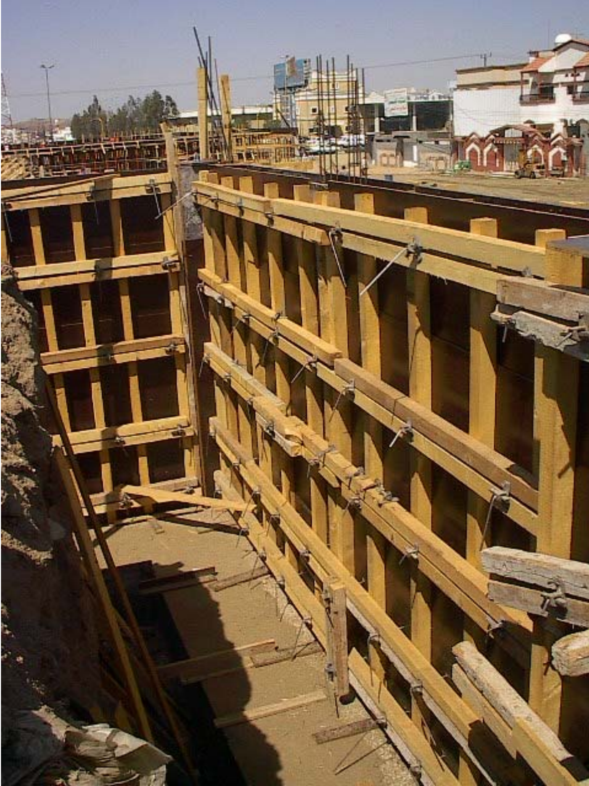
شكل رقم (٢٢) يبين متانة أعمال الشدات الخشبية لحائط خرساني
