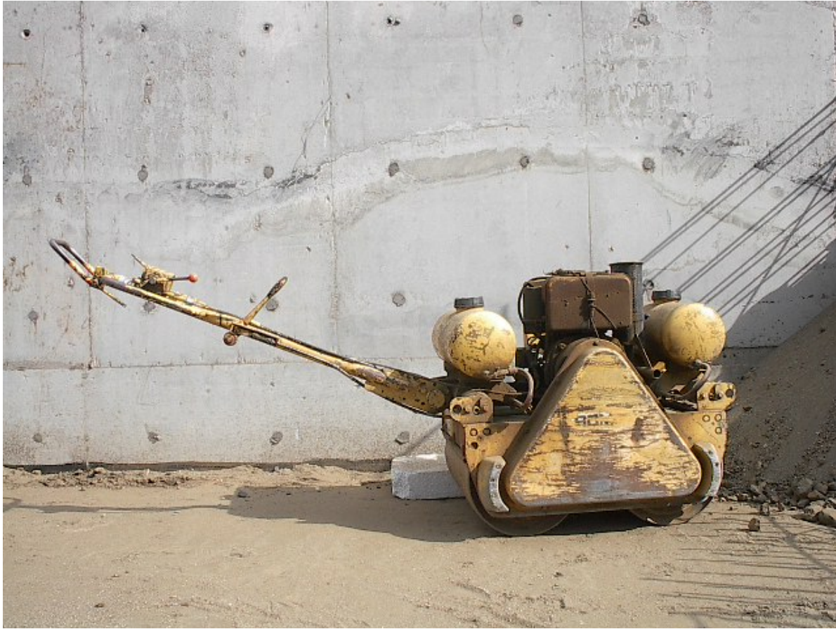
شكل رقم (١٢) أعمال دك التربة داخل أحد المباني
