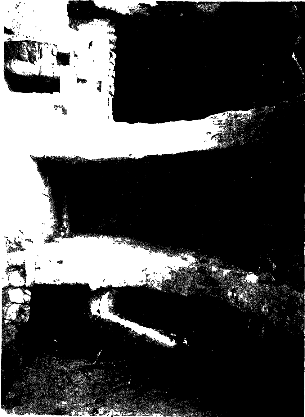
اسلوب التوزيع الداخلي لعناصر البناء في مسكن تقليدي قديم، يتوسط المسكن قنطرتان والقواطع التي تتخللها تستخدم كاجزاء للتخزين (زاوية) ومصاطب للمنام
