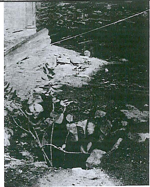
لوحة رقم (٢٦): قلعة لعلج: أسلوب تسقيف خزائن الماء الذي كشف عنه انهيار ناتج عن مياه الامطار.
