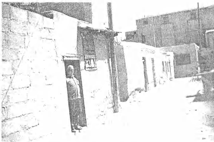
لاحظ استخدام البلوك في البناء لكن الطريق ترابي غير معبّد
