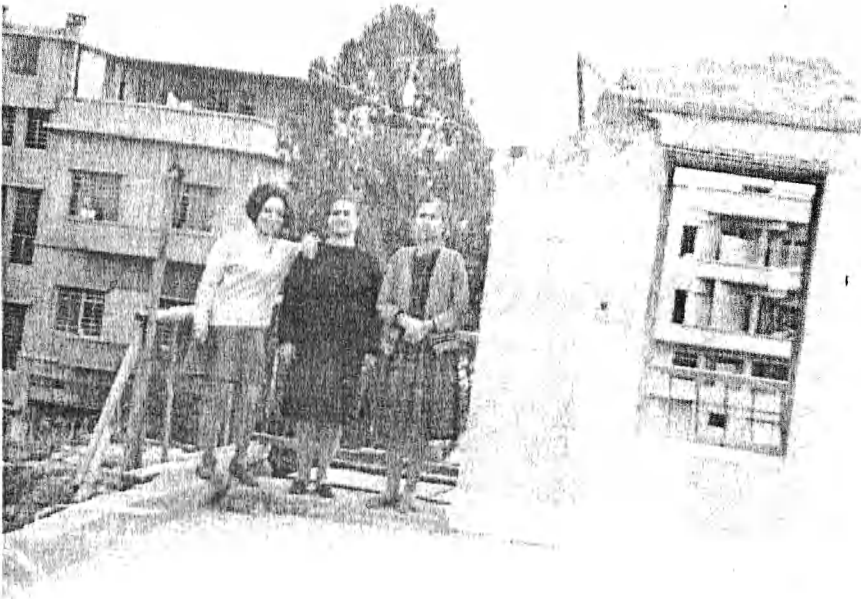
أحد بيوت تجمع العبارة بعد انهيار سقف الطابق الثاني خلف الصورة نلاحظ بناء معمل فريش أبو القديم للمياه الغازية
