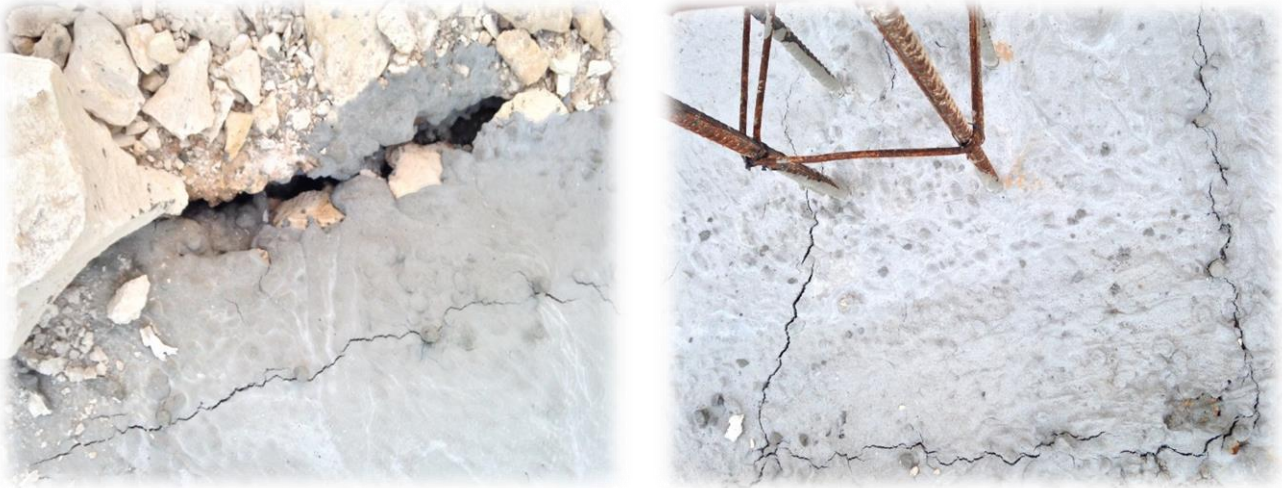
الشكل (7-6) يوضح أساسات متشققة نتيجة سوء التنفيذ
