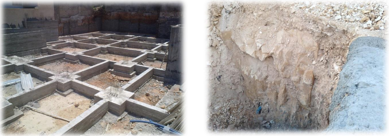
شكل (9-6) يوضح مقارنه بين الأساسات المنفذة بطريقة خاطئة والأخرى المنفذة بطريقة صحيحة
