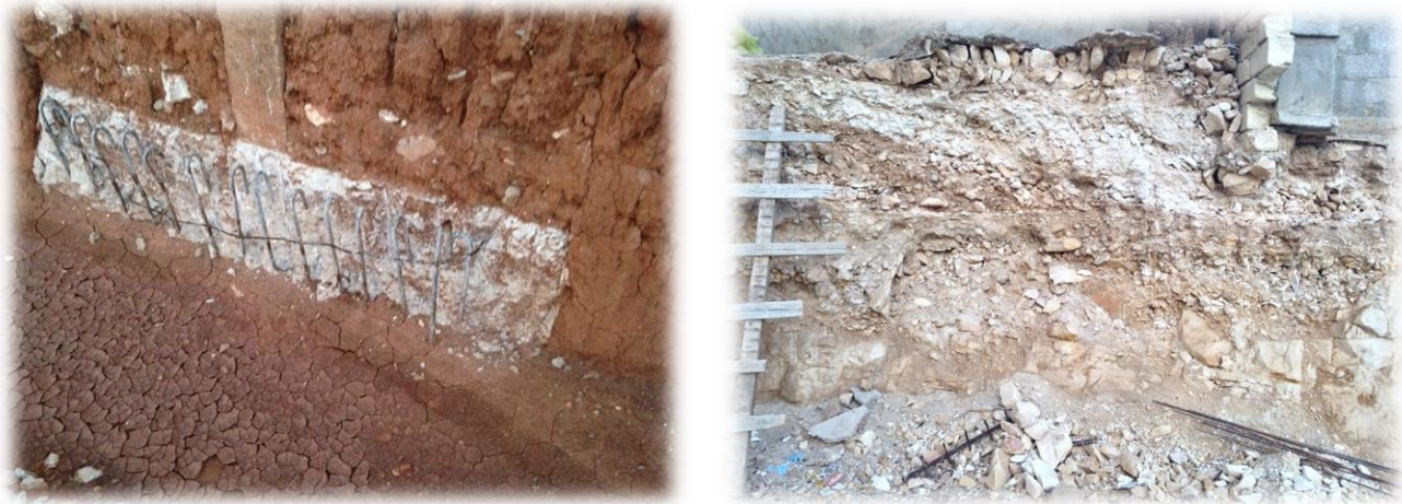
شكل (8-6) يوضح الاهمال في تنفيذ الأساسات والتعدي على الأساسات المجاورة
