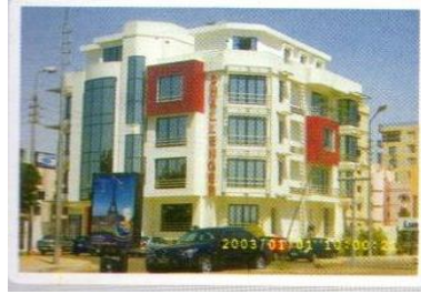
تعليه مبنى شركه challenger
