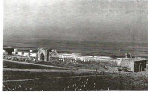
برج الدار : منظر عام قبل الترميم (1981)
