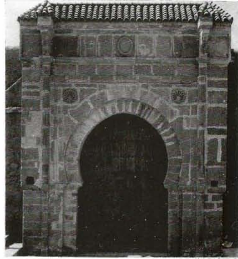
برج الدار : المدخل بعد الترميم
