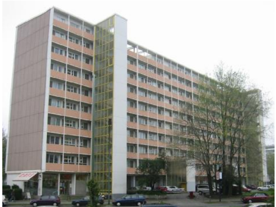
شكل رقم (18) يظهر حالة الفتحات الأفقية المسيطرة في خطوط الواجهة وكذلك خطوط رأسية تكسر الملل في الخطوط الأفقية من خلال عناصر الحركة الرأسية (الدرج)
